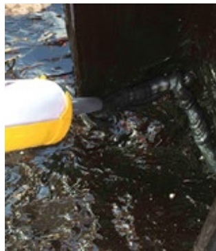
Aplikace elastomerní pryskyřice jako hydroizolační vrstvy.
