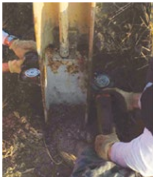
Příprava povrchu na Sa 2½ nebo St 3 a drsnost R a > 60 pm.
