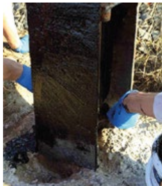
Aplikace epoxidové pryskyřice pro ochranu stožáru/betonu.
