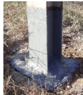
Aplikace ochranného nátěru.
