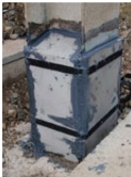
Montáž kovových výztuh.
