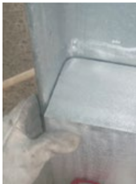
Příprava kovových výztuh.
