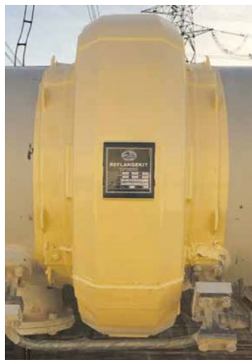
Po instalaci sady ReflangeKit
